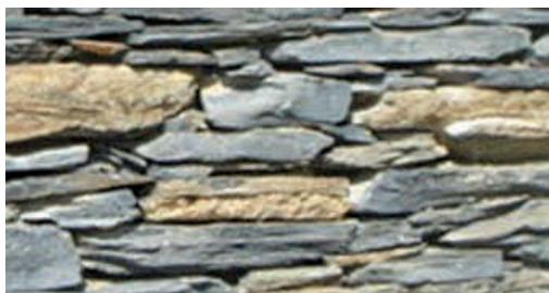
а) кладка из бутовых (карьерных) камней; б) кладка из натуральных камней
