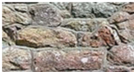
б) кладка строительным раствором
